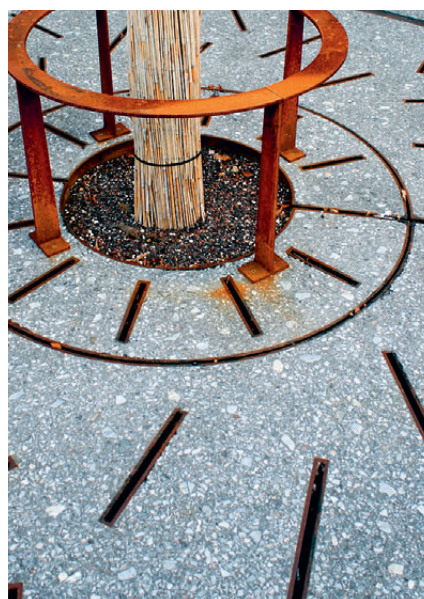
Gussasphalt mit Basaltschotter (22/32) abgestreut und abgeschliffen.
