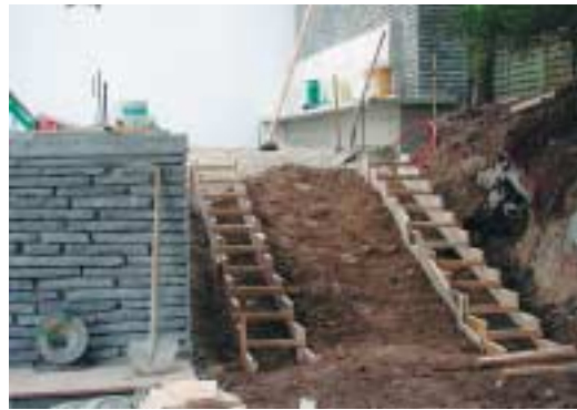
Unterbau der Treppe. Sous-construction de l'escalier.
