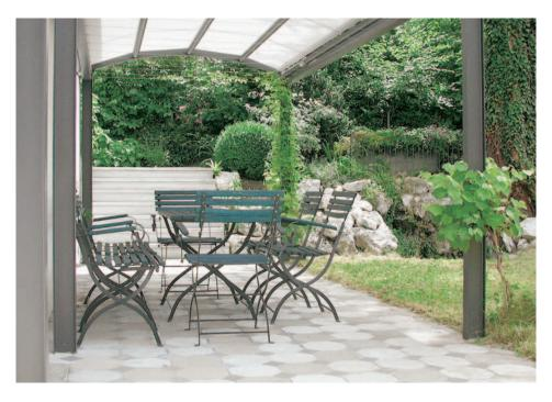
viele: alte und neue Platten regelmässig abwechselnd gemischt, alte Platten in der Mittte der Fläche verlegt und mit den neuen umrandet. Schliesslich entschied man sich, Alt und Neu auf der ca. 40 m² grossen Fläche möglichst unregelmässig zu streuen. Andere Varianten schienen zu künstlich, zu aufgesetzt, zu unklar in der Interpretation. Da die Platten relativ dünn sind, wurden sie auf ein Mörtelbett verlegt.
