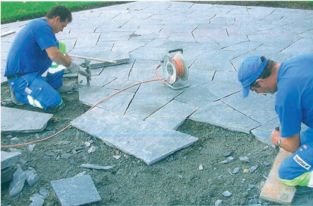
Das Bekanten der Platten erfordert gute Kenntnisse des Steins und viel Zeit.
