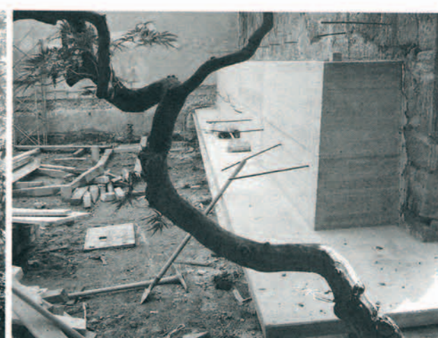
Abb. 8: Betonfundament und Betonkern
