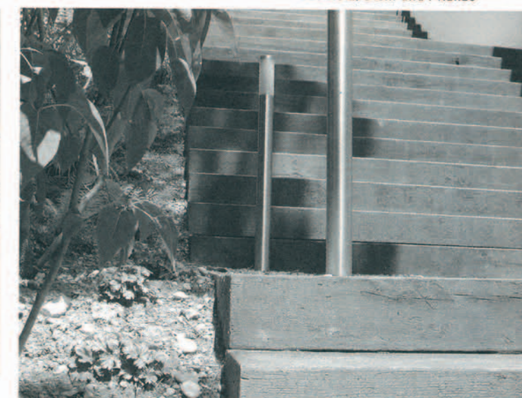
Abb. 2: Treppenanlage aus gekohltem Holz
