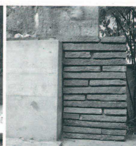
Abb. 9: Natursteinmauerung
