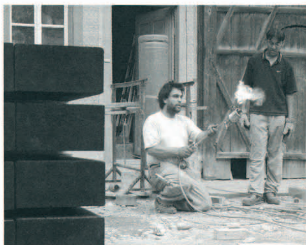
Abb. 3: Beflämmen der Eichenbalken
